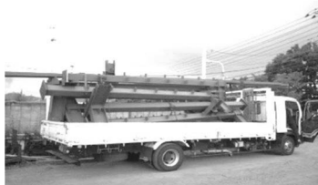
鉄骨柱 5m 輸送
